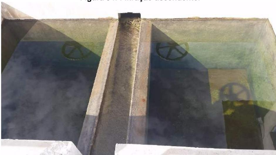
Antes de ser recalçada para o sistema de distribuição, a água passa pelo tanque de contato, vide a Figura 35, onde é aplicado o gás cloro e o fluorsilicato de sódio para garantir a desinfecção e a fluoretação da água tratada.
