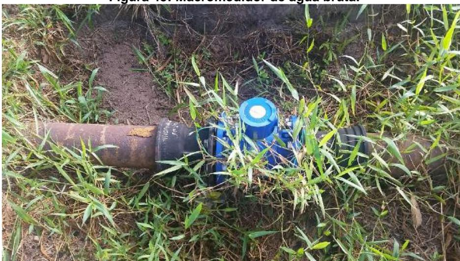
**Figura 46: Macromedidor de água tratada.**
