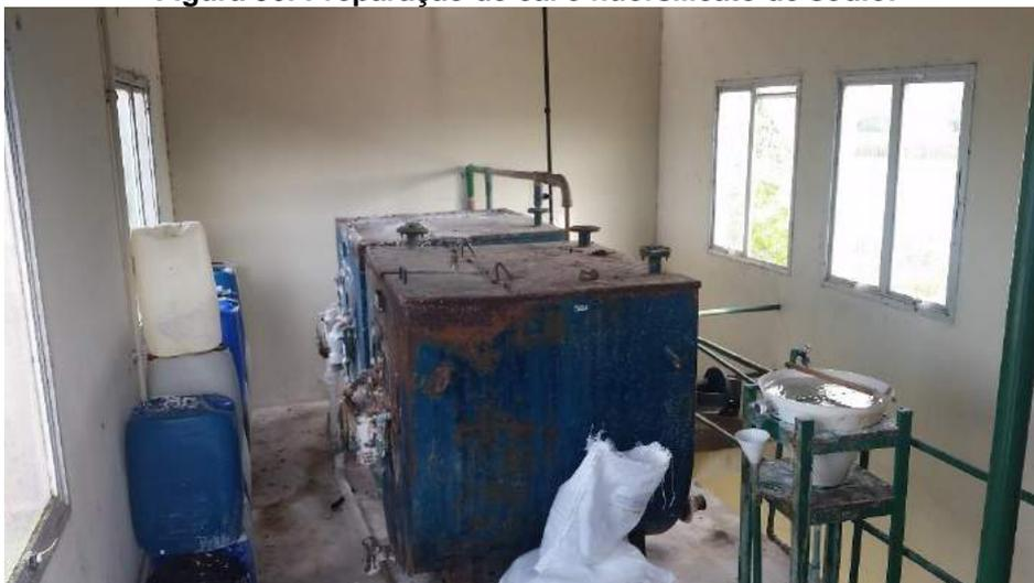
**Figura 37: Tanques de cloro gasoso.**
