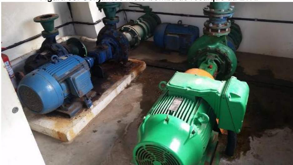
O CMB azul é o mais antigo, trata-se de um motor WEG com potência de 40 cv e velocidade de rotação de 1770 rpm, enquanto a bomba é uma KSB Meganorm com vazão máxima de 126 m<sup>3</sup>/h (35 L/s) e altura manométrica de 50 mca.
