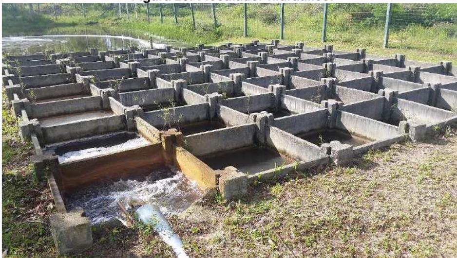
**Figura 29: Chegada de água bruta no floculador hidráulico.**
